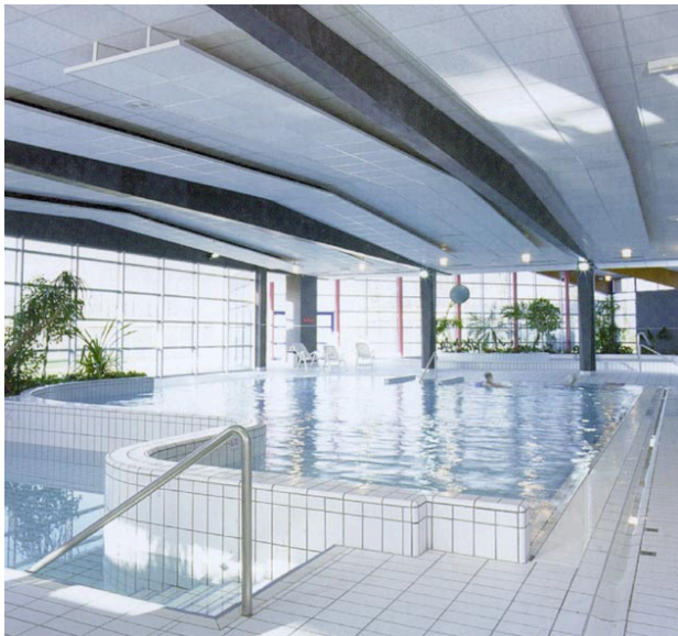
Fot. 14 Basen z sufitem obłożonym panelami dźwiękochłonnymi
