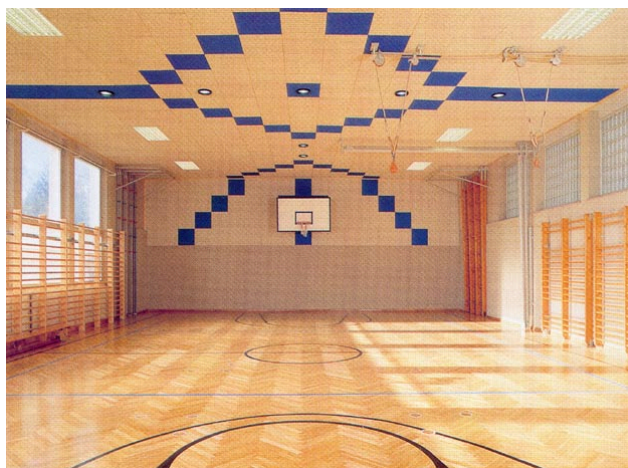
Fot. 13 Sala sportowa z wytłumieniem w postaci płyt z wełny drewnianej
