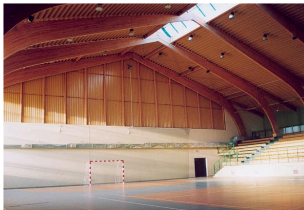
Fot. 17 Dach hali ma falista strukturę rozpraszającą dźwięk
